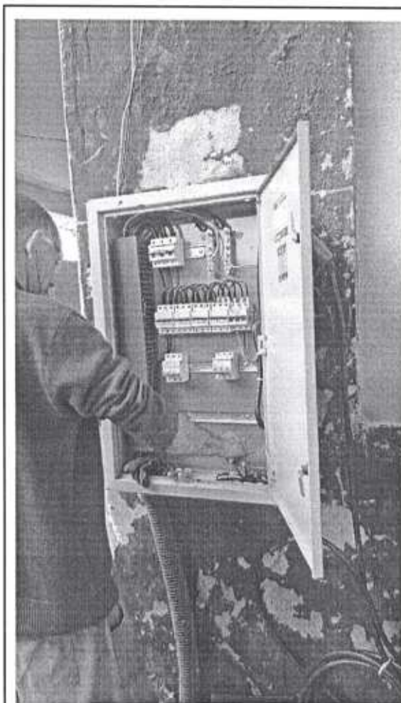
Figura 13 - Instalação do quadro de energia;
