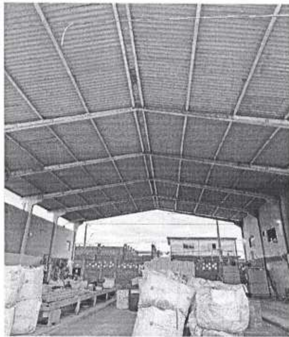
Figura 15.2 - Foto geral do telhado.
