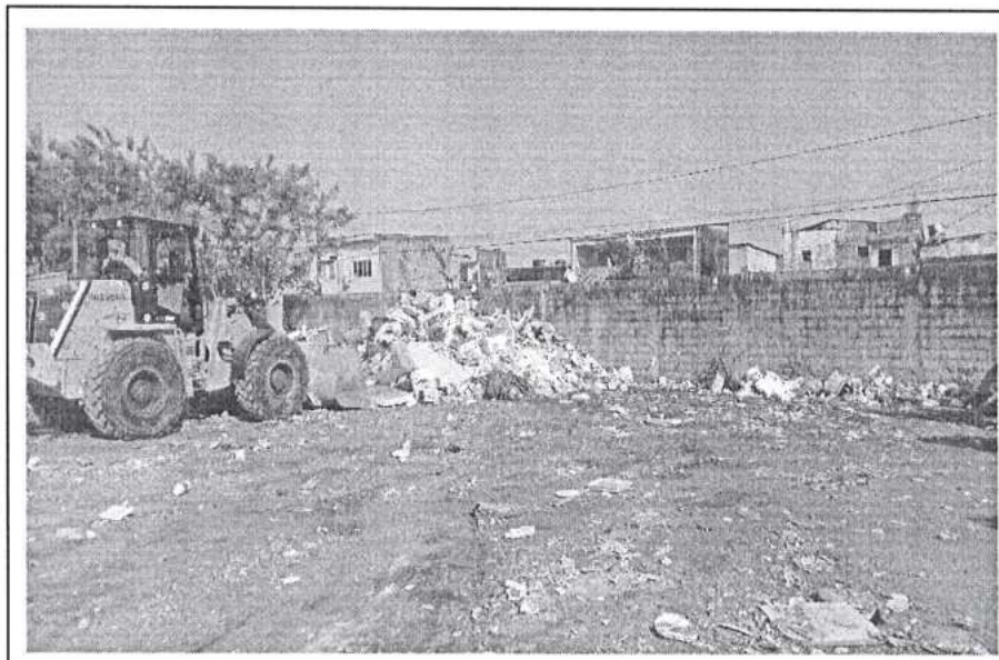
Figura 13 - Retirada do Rejeito
