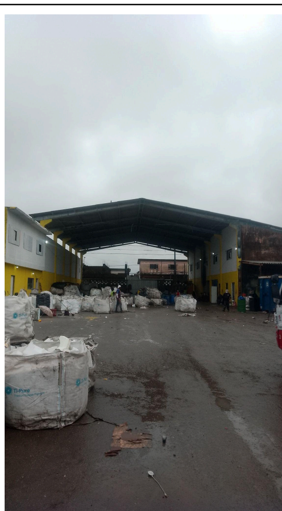
Figura 11 - Obras de adequação do espaço: telhados finalizados
